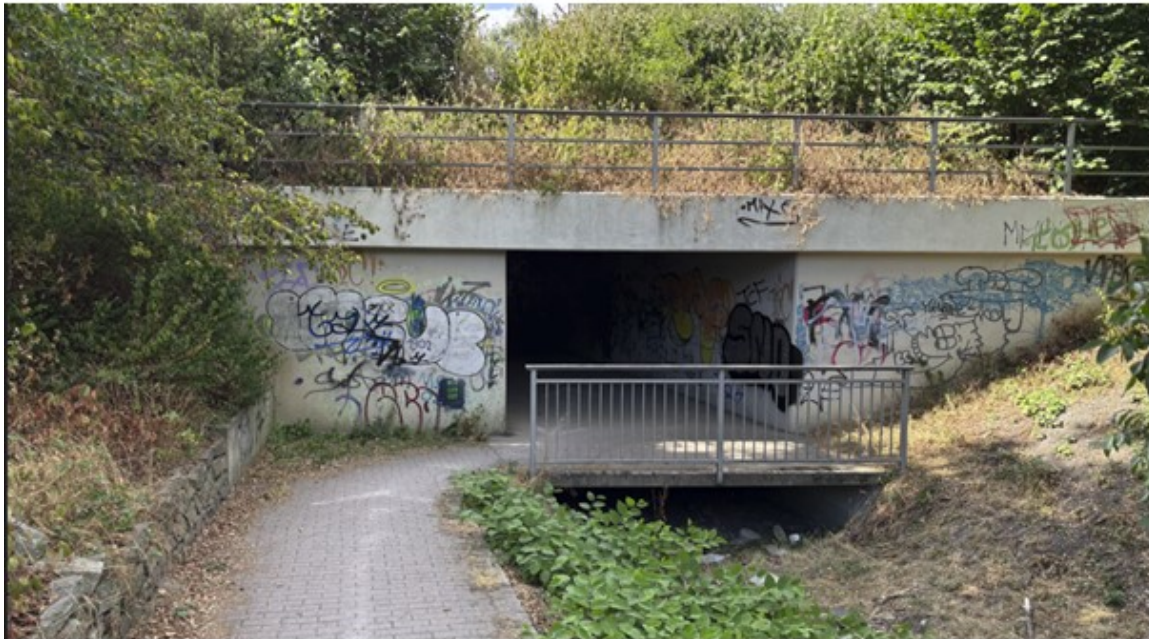
Abbildung 1: Eingang der Unterführung an der Lauerstraße in Richtung Friesenplatz
